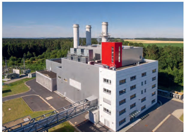
Das unternehmenseigene Kraftwerk mit kombiniertem Gas- und Dampfturbinenprozess.
