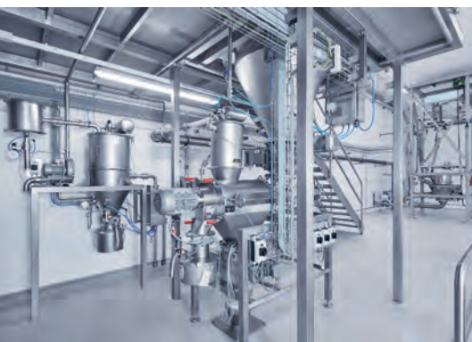
AZO Anlage im Hygienic-Design. Im Zentrum die Wirbelstrom-Siebmaschine DA650 mit Magnetabscheider. Fotos: AZO
