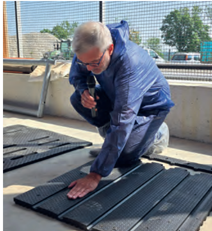
profiDRAIN – durch die gewölbte Oberfläche wird Harn in die Rinnen geleitet und in regelmäßigen Abständen mit dem Schieber abgezogen.
