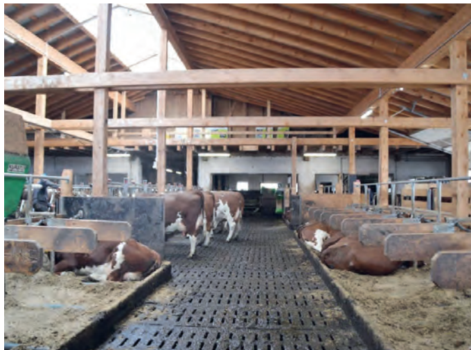
Klassische Dachkonstruktion, bei der besonders Wert auf die Luftführung gelegt wurde. Der Lichtfirst öffnet und schließt vollautomatisch.
