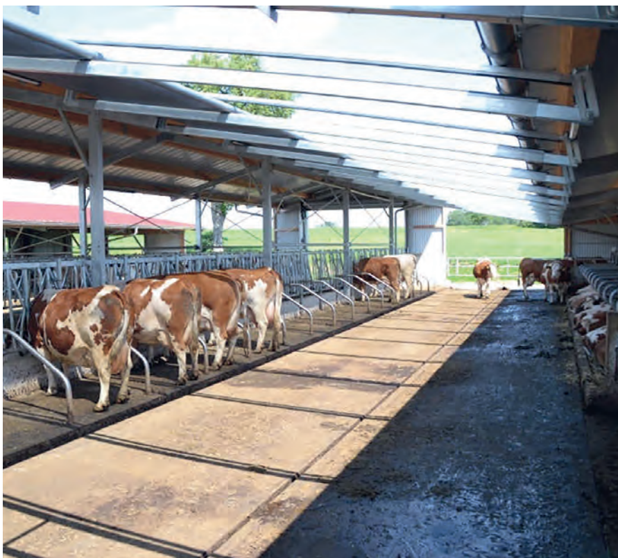
Die sensorgestützte Jalousie verringert den Wärmeeintrag am Fressplatz. Gerade bei der Futteraufnahme sollte Hitzestress vermieden werden. Daher ist zusätzlich an der vorhandenen Konstruktion eine Kuhdusche installiert.
